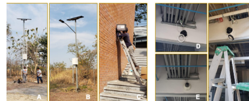
Imágenes A, B y C: instalación y mantenimiento de las luminarias en áreas faltantes, D, E y F: mantenimiento de cámaras Hikvision para reforzar la seguridad institucional.
