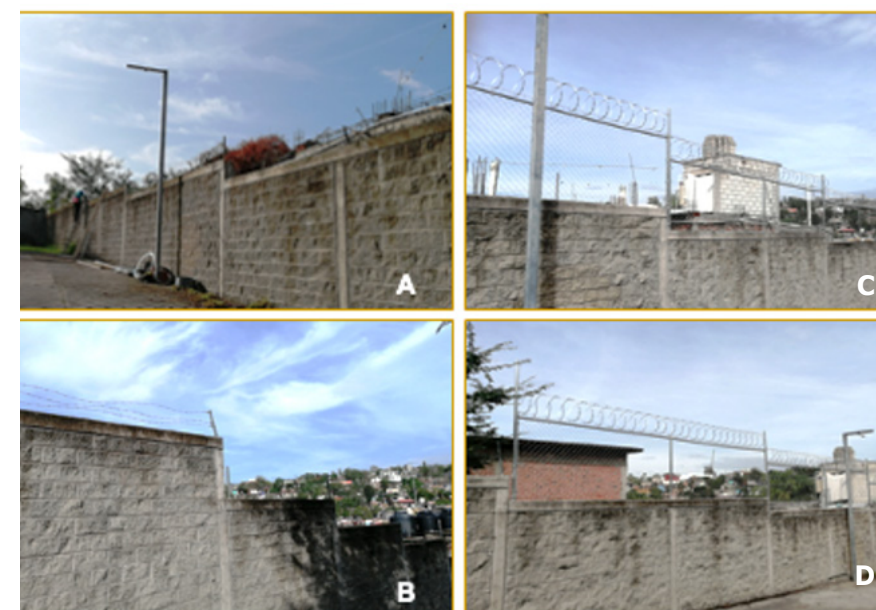
Imágenes A y B: infraestructura con necesidades de atención urgente, C y D: posterior a la atención de las necesidades de infraestructura.
